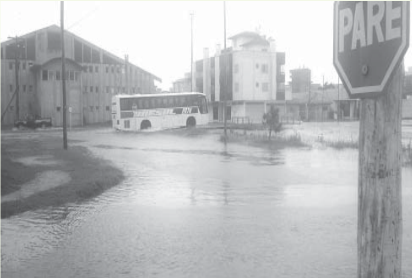
Av. Martinho Jovino Espindola, próximo a estação rodoviária, e seus constantes alagamentos, por falta de limpeza do Arroio da Pescaria
